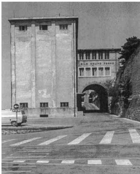
Il Silo Molino Forno (progetto dell'ing. Gino Zani) inaugurato il 22 settembre 1940.
